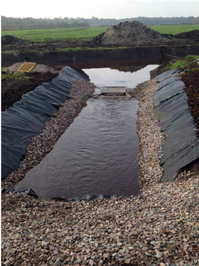
Abbildung 9: Abflussmessstelle am Graben Nr. 133 (21.11.2014).
