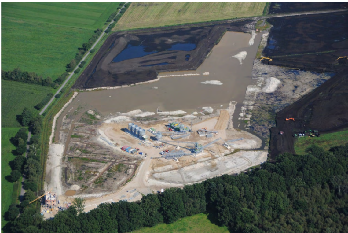
Abbildung 2: Stand des Abtrags von Torf und Boden bis auf die Deckschicht des Hauptaquifers zum 04.09.2015.
