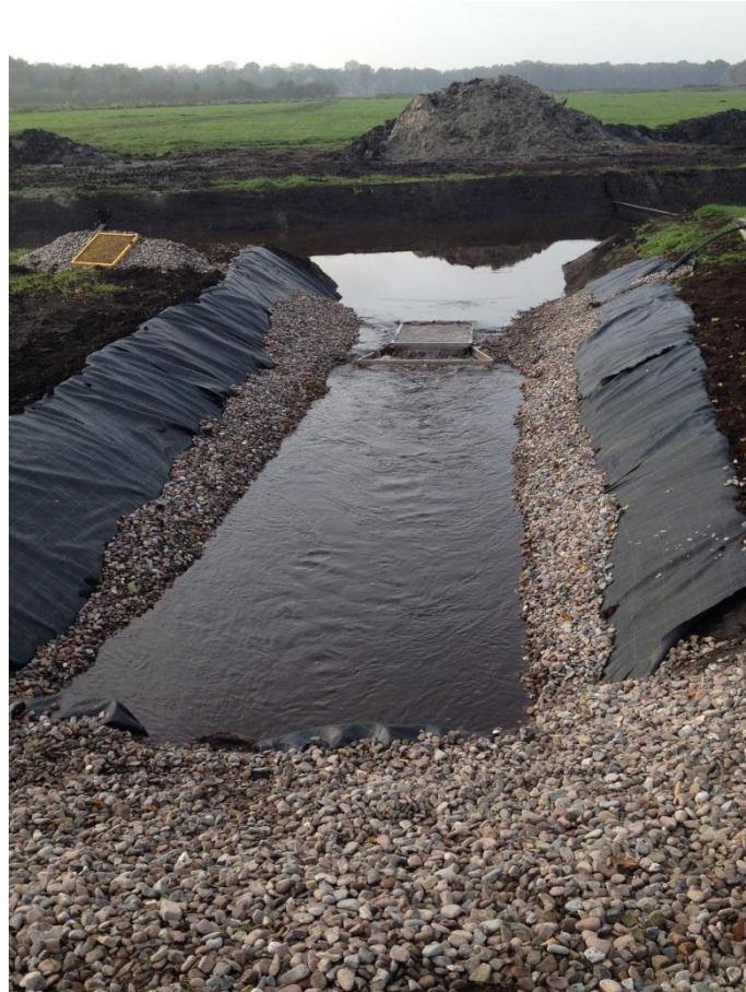
Abbildung 10: Abflussmessstelle am Graben Nr. 133 (21.11.2014).
